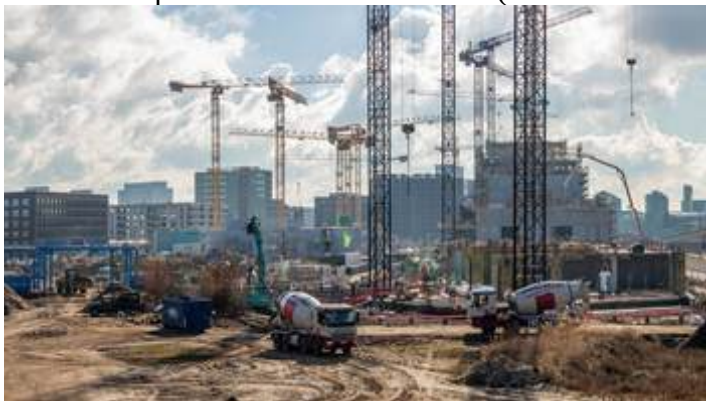
https://cdni.russiatoday.com/deutsch/images/2022.05/article/6296319ab480cc69bb1605bc.jpg Bebauung der "Europacity" in Berlin, Baustelle Quartier Heidestrasse, März 2021
